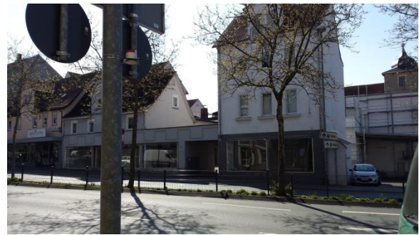
Abb. 5: Standort Rodensteinstraße (in Höhe der Hausnr. 7); Foto: Hessisches Landesamt für Naturschutz, Umwelt und Geologie
